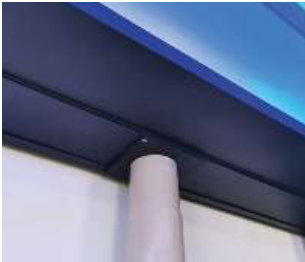
INTÉGRATION DE DESCENTE D'EAU PLUVIALE Intégration des gouttières déjà existantes. Sur étude de faisabilité.
