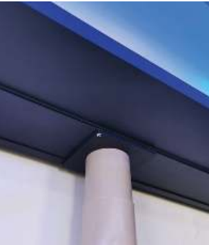
INTÉGRATION DE DESCENTE D'EAU PLUVIALE Intégration des gouttières déjà existantes. Sur étude de faisabilité.
