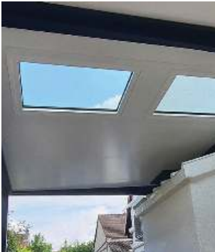
HUBLLOT DE TOIT En fonction des dimensions, intégration d'un ou plusieurs hublots de toit.
