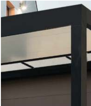
PUITS DE LUMIÈRE Panneaux polycarbonate.
